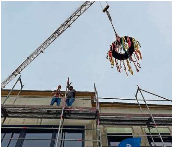
In Wassenberg wurde jetzt Richtfest gefeiert für die Schaffung von neuem, barrierefreiem Wohnraum für Menschen mit Behinderung.
